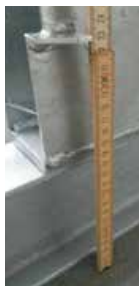
Inbouwdiepte van de stalen drager (circa 22,5 cm)
