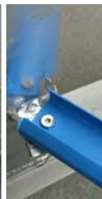
Montage van de aansluitstukken bodemrails
