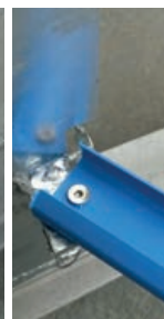
Montarea șinelor de bază piese de racordare
