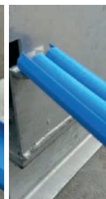
Introducerea șinei de bază la montantul de oțel
