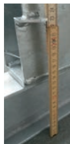
Adâncimea de introducere a montantului de oțel (cca. 22,5 cm)
