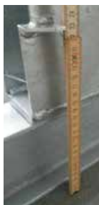
Vstavaná hĺbka oceľových nosníkov (cca. 22,5 cm)
