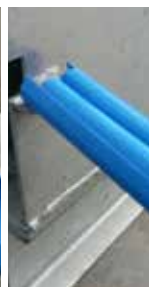
Nasunutie podlahovej lišty na oceľový nosník
